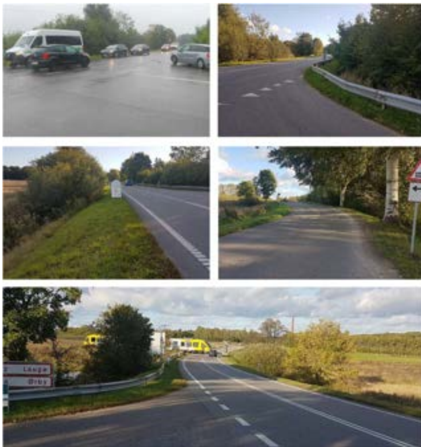
Figur 5-11 Øverst til venstre: Bil afventer mulighed for at svinge i venstre. Bagved opstår kø, da de øvrige biler ikke kan passere uden om den venstresvingende bil. Øverst til højre: Oversigten i højre for udkørende bilister er i nogen grad begrænset af beplantning. Det er dog vurderet på stedet, at oversigten er tilstrækkelig i forhold i vejreglerne, bortset fra at en tavle står i oversigtsarealet. Der er behov at kunne se omtrent i byzonetavlen mod syd (til højre) på Valbyvej. Mod nord (til venstre) er der behov for at se lige forbi jernbaneoverskæringen. Midterst til venstre: Der er stor niveauforskel øst for vejen (samt enkelte faste genstande), som øger risikoen for uheld og alvorlig personskade, når uheldene sker. Midterst til højre: Laugøvej ligger lavt i forhold i Valbyvej, hvilket kan forstyrre trafikanten ved sving i og fra Laugøvej. Det er vurderet på stedet, at niveauforskellen ikke har betydning for oversigten. Nederst: Køresporene er smalle, men i gengæld er der relativt brede kantbaner i begge sider.
